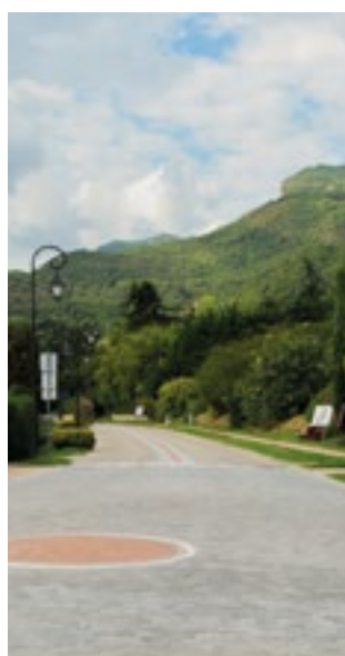
La voirie de la rue du Rafour entièrement rénovée.
